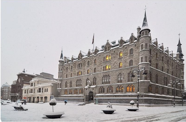
Ilustración 7: Botines nevado. http://www.ojodigital.com/foro/urbanas-arquitectura-interiores-y-escultura/300386-edificio-botines-gaudi-leon-nevado.html
