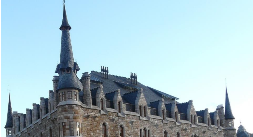
Ilustración 10: tejado, con las escamas de pizarra y el perfil que evoca el lomo del dragón.
