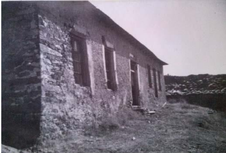
Ilustración 8. Escuela de Villar de los Barrios de Nistoso. Año de construcción 1930
