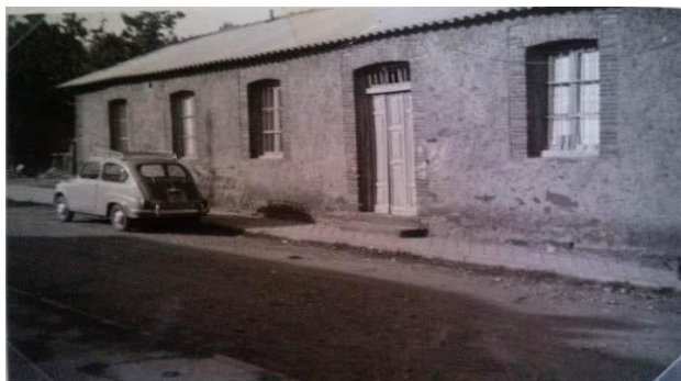
Ilustración 7. Escuela de Villameca. Año de construcción 1928
