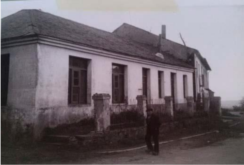
Ilustración 3. Escuela de Manzanal del Puerto. Año de construcción 1900
