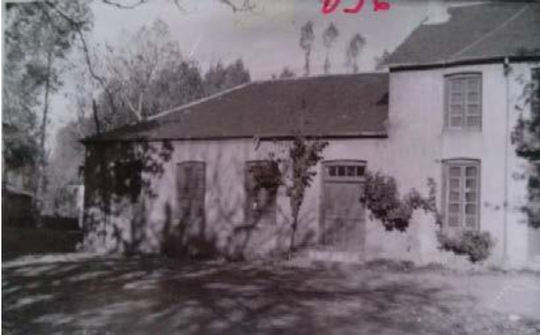
Ilustración 12. Escuela de Donillas. Año de construcción 1952
