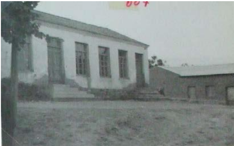
Ilustración 13. Escuela de Ferreras. Año de construcción 1954
