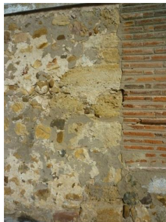
Fotos J. Santos. Pared del campanario de la iglesia de Azadinos. Las paredes parecen ser las originales de la fábrica, con un sistema constructivo similar al que fuera de la torre de ladrillo original de la iglesia de Carbajal.
