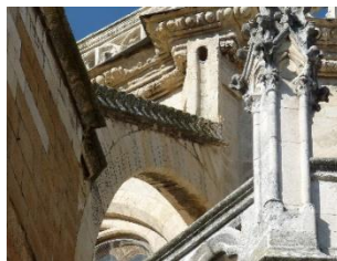
Fig. 7. Agujero de desagüe con revestimiento
