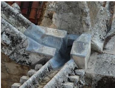
Fig. 1. Canalización en cruce de arbotantes
