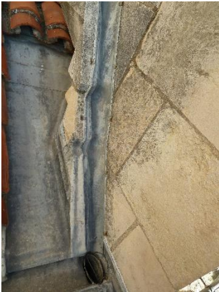
Fig. 3. Canal de desagüe y rejilla circular
