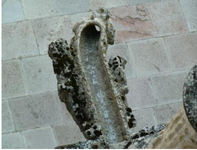
Fig. 15. Canalón limpio de gárgola
