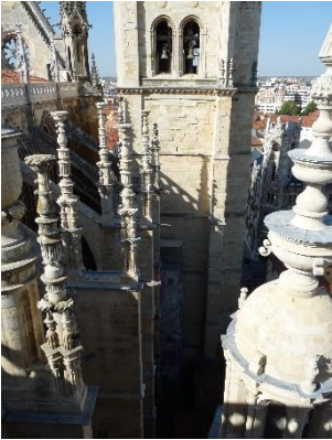
Fig. 21. Costado norte (nave lateral)
