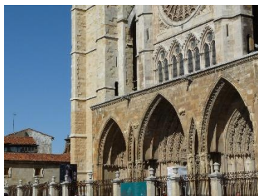
Fig. 57. Fachada oeste (pórticos)
