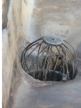
Fig. 4. Rejilla circular (detalle)
