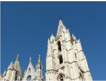
Fig. 59. Torre sur (muro oeste)
