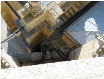
Fig. 5. Canalones de gárgolas revestidos y limpios
