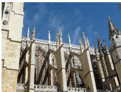
Fig. 51. Costado sur (nave lateral)
