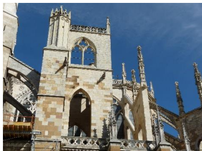
Fig. 37. Costado sur (Capilla del Carmen)
