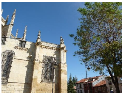
Fig. 34. Fachada este (oratorio)
