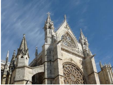
Fig. 49. Fachada sur (transepto)
